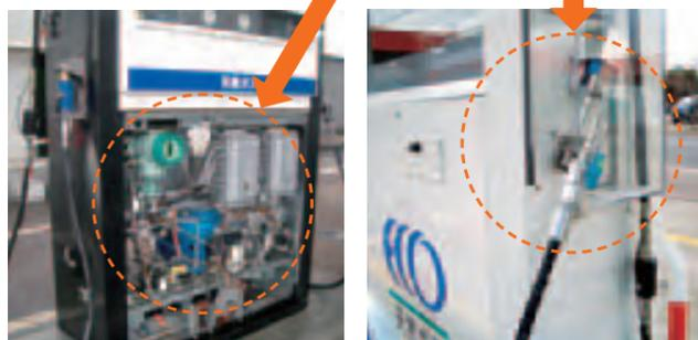
ディスペンサーユニット (写真左: 札幌市中央卸売市場内の中央卸売市場天然ガススタンド)と充填ホースのノズル部分 (写真右: 発寒エコ・ステーション)で使われる高圧ガス体用ボールバルブ
